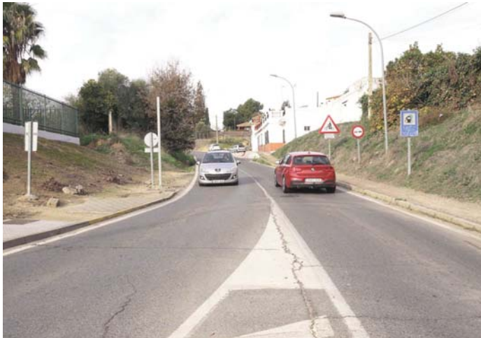
La carretera A-8063. JUNTA DE ANDALUCÍA
